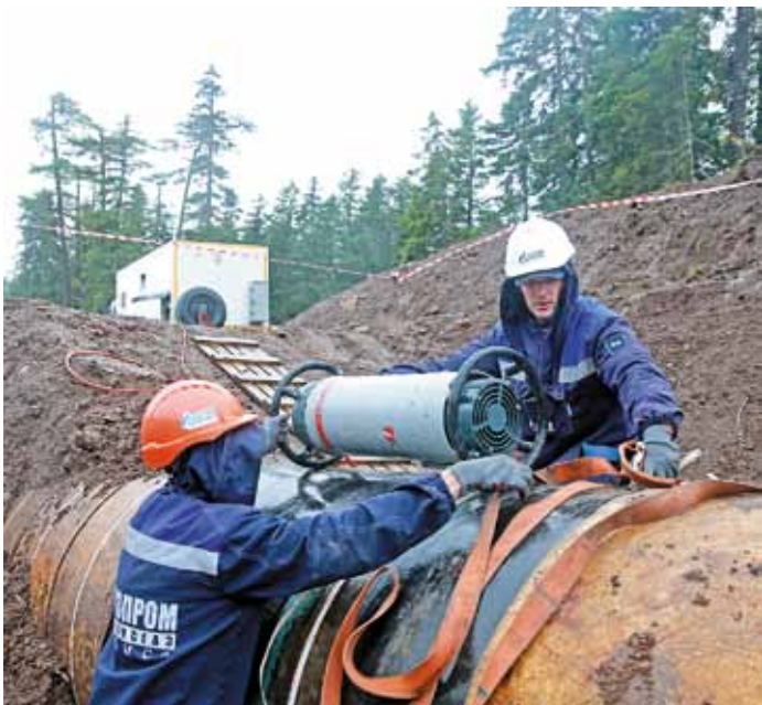
Работники Амурского ЛПУМГ диагностируют надежность сварного стыка, а специалисты инженерно-технического центра помогают им провести анализ
