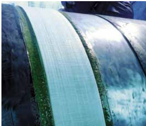
Так выглядит участок трубы, на который наложена композитная муфта
