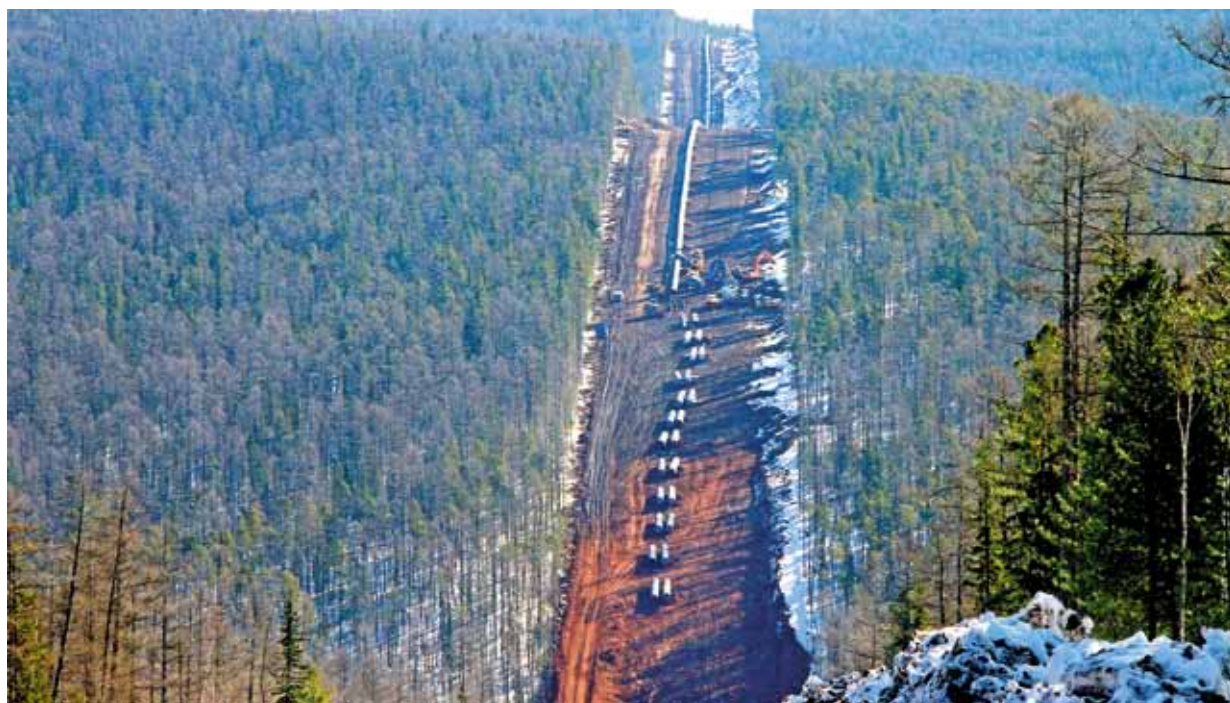
При строительстве магистрального газопровода «Сила Сибири» было пройдено немало сложных участков
