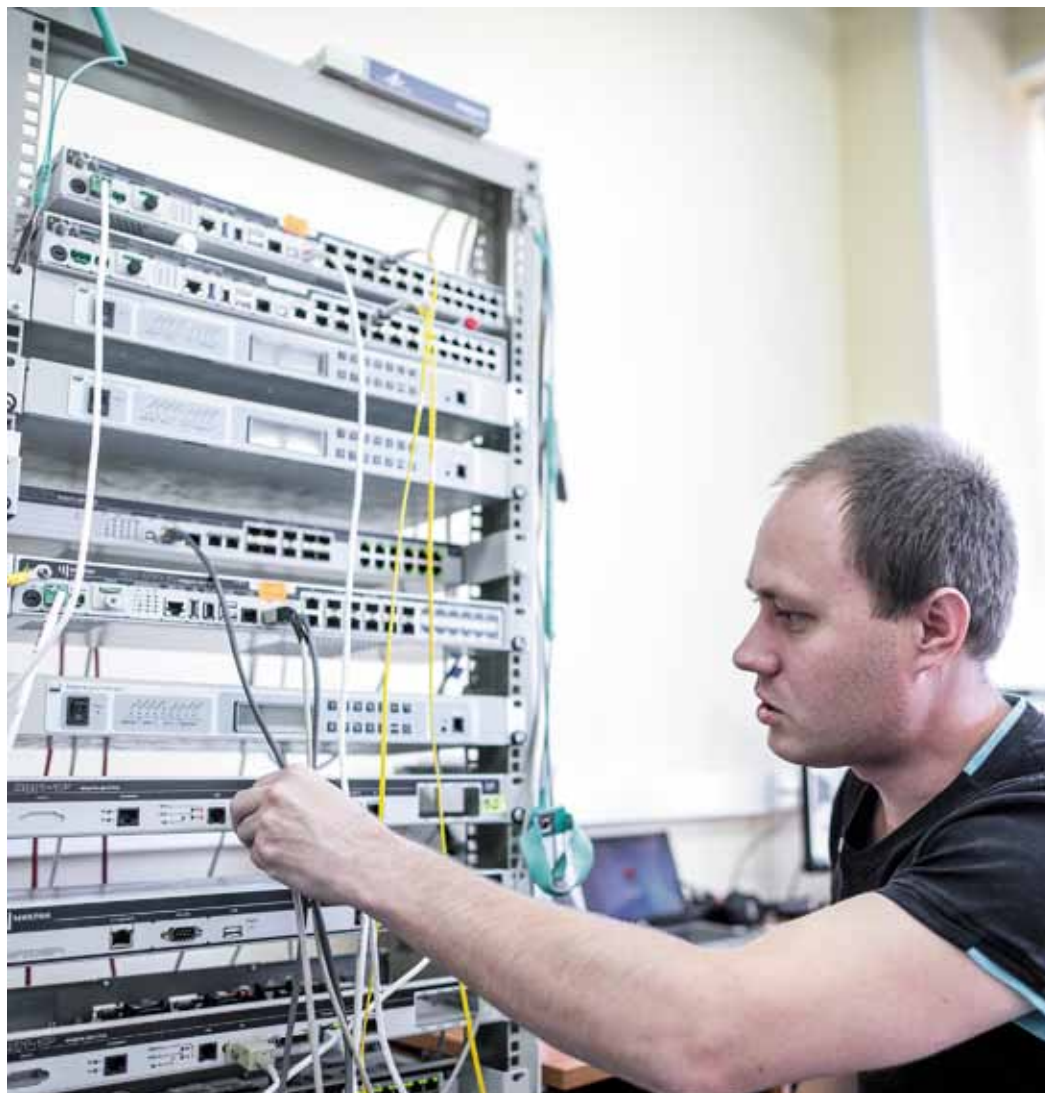
Инженер Алексей Подбельский проводит заводские испытания оборудования
