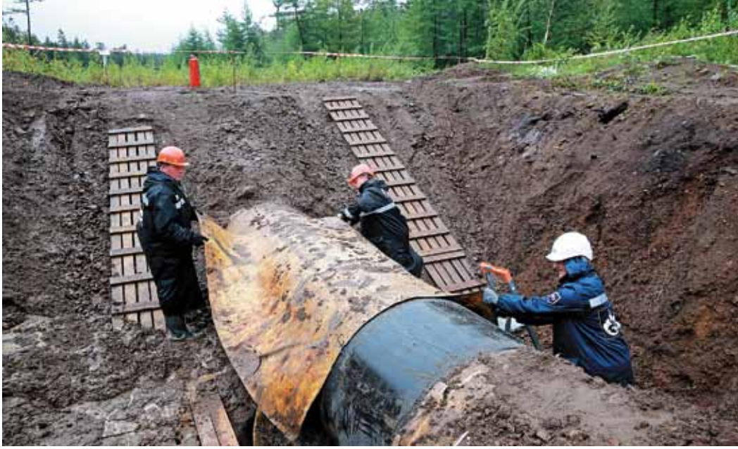
Диагностика газопровода проводилась в сложных условиях: на Дальний Восток обрушился тайфун «Джеби»
