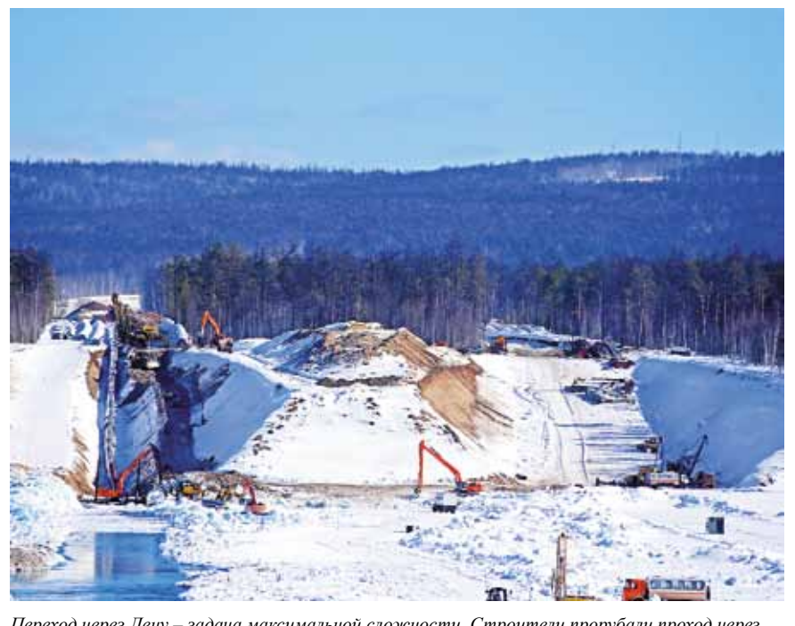
Переход через Лену — задача максимальной сложности. Строители прорубали проход через скалу, проводя горно-взрывные работы
