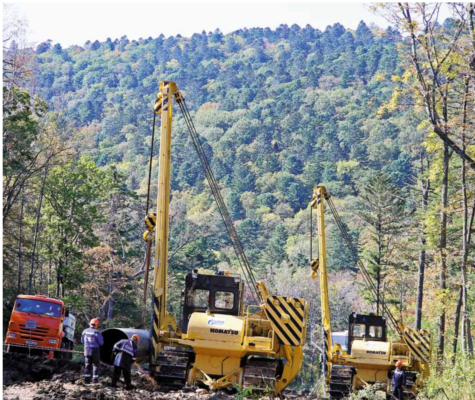
Основные работы в Приморском ЛПУМГ
